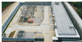
云浮35千伏太平输变电工程
