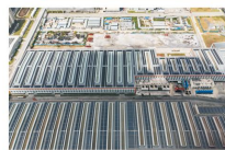
云浮市合信实业有限公司金兰二期光伏电站
